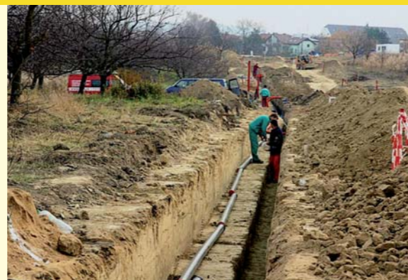
Ve stavební zóně Padělký nastal čilý stavební ruch, začalo se zde s další rozsáhlou výstavbou, které předcházelo rozvedení rozličných sítí do zemi. Foto: Ing. Zdeněk Karber
